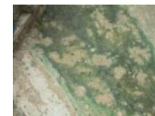
圖4 釉料風化後片狀缺損
