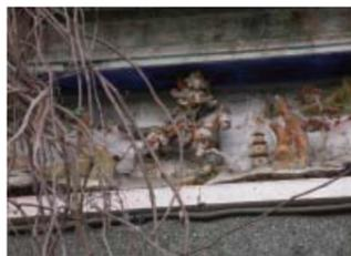
圖6 植物生長推擠容易造成折損
